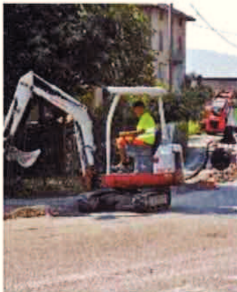
LAVORI Gli operai impegnati a installare le fibre ottiche
