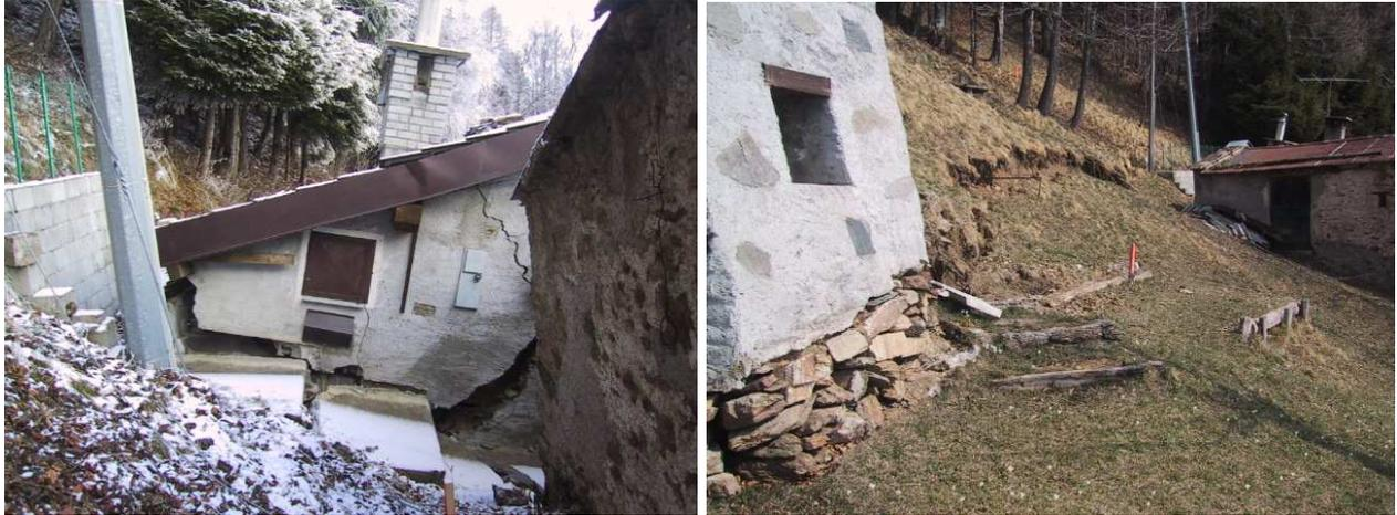
**Figura 9** – Edificio danneggiato a seguito del movimento franoso (a sinistra); nicchia della frana (a destra).
