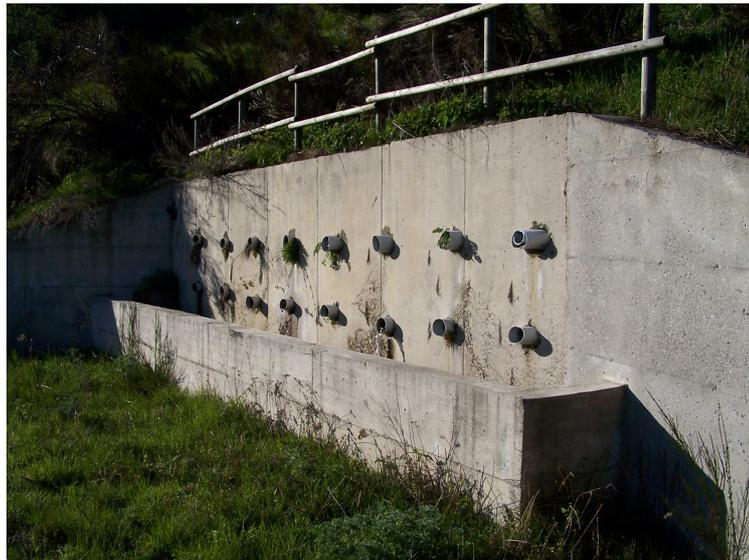
**Figura 10** – Casello di raccolta del sistema di drenaggio
